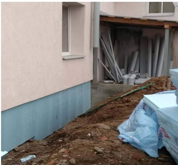
Attēls 1. Pamatu un cokola siltināšana.
