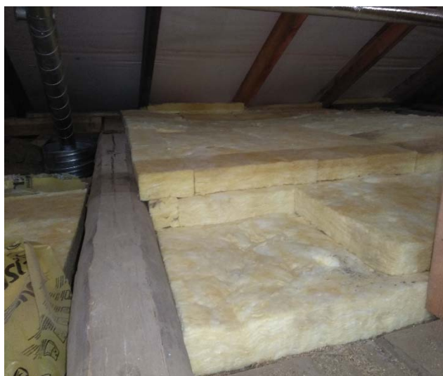
Attēls 4. Bēniņu siltināšana.
