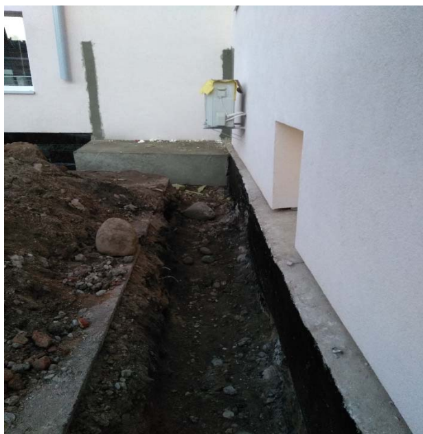
Attēls 2. Pamatu un cokola siltināšana.
