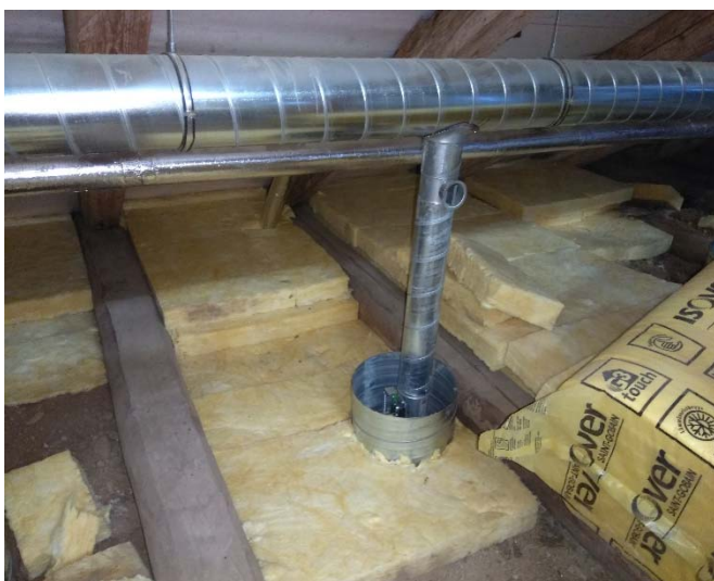
Attēls 3. Bēniņu siltināšana.
