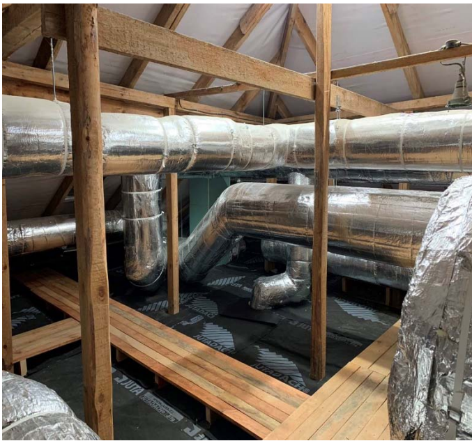
Attēls 1. Bēniņu siltināšana ar koka lapu izveidi.
