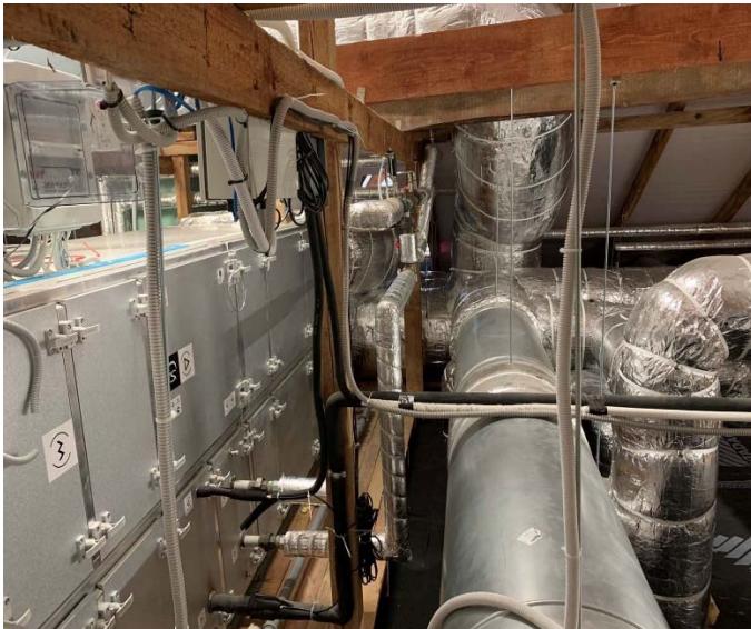
Attēls 3. Ventilācijas sistēmu gaisa vadu montāža.
