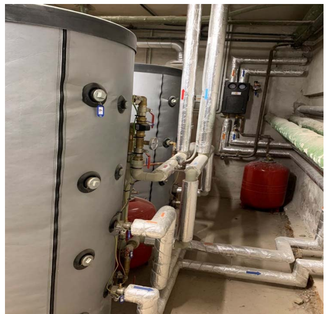
Attēls 6. Siltummezgla nodošana ekspluatācijā.
