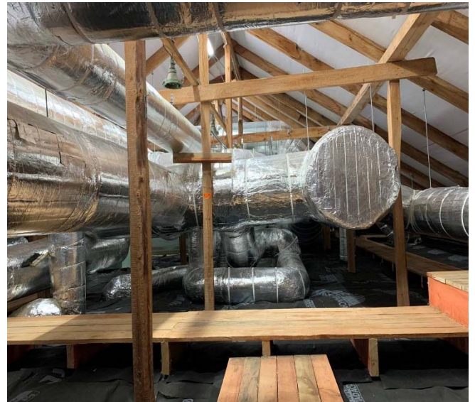
Attēls 4. Ventilācijas sistēmu gaisa vadu montāža.
