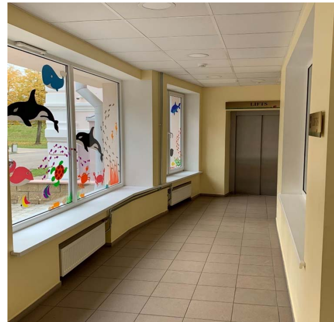
Attēls 10. LED gaismekļu, ventilācijas difuzoru sildelementu uzstādīšana.
