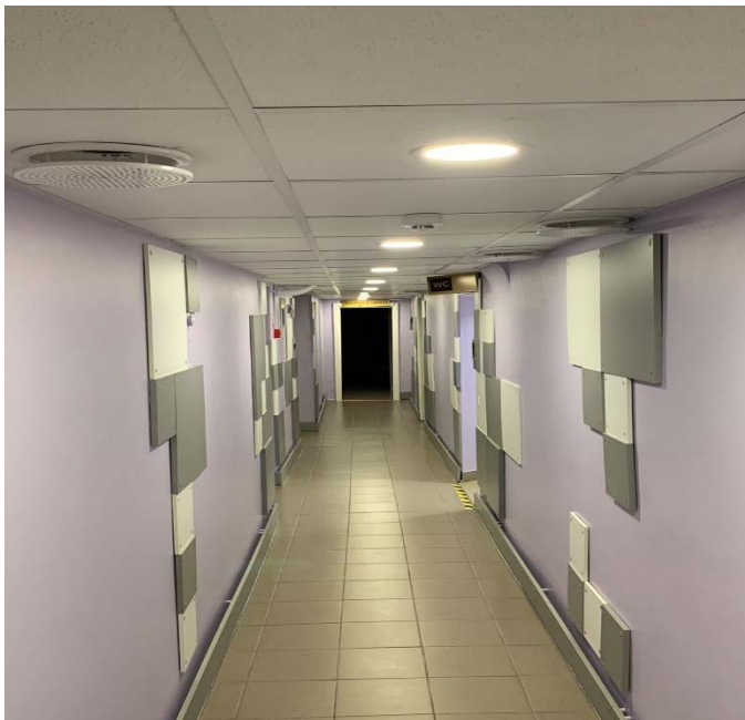
Attēls 9. LED gaismekļu, ventilācijas difuzoru sildelementu uzstādīšana.
