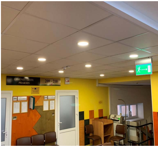
Attēls 7. LED gaismekļu, ventilācijas difuzoru, sildelementu uzstādīšana.
