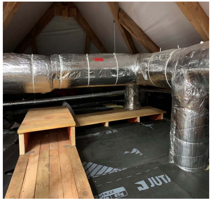
Attēls 2. Bēniņu siltināšana ar koka lapu izveidi.
