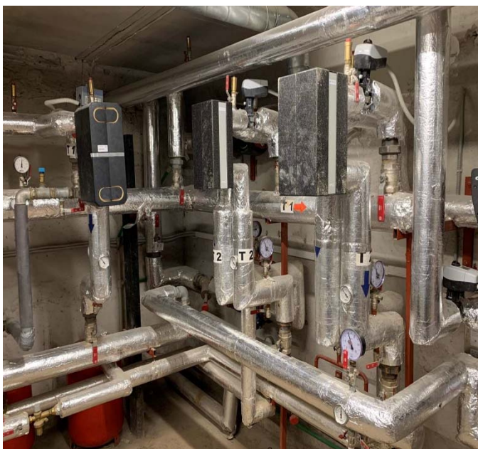
Attēls 5. Siltummezgla nodošana ekspluatācijā.
