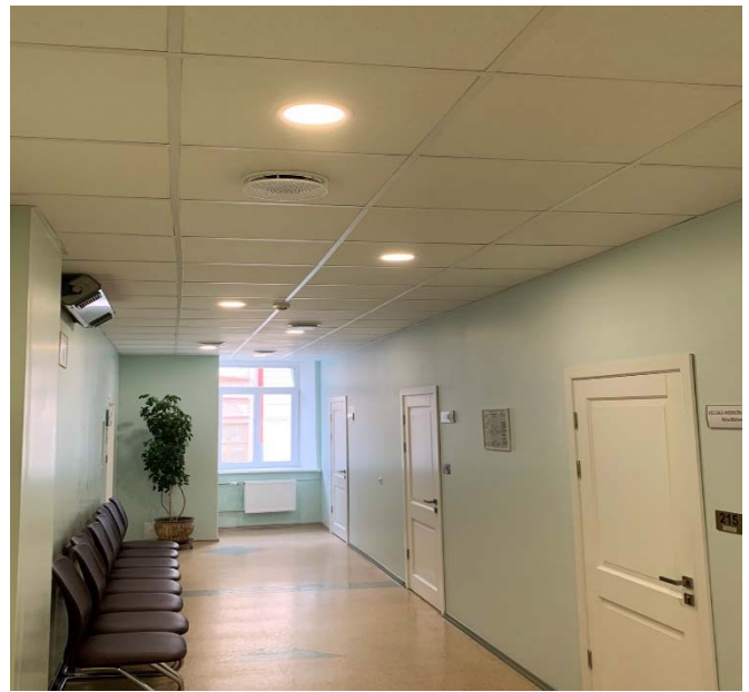
Attēls 8. LED gaismekļu, ventilācijas difuzoru, sildelementu uzstādīšana.
